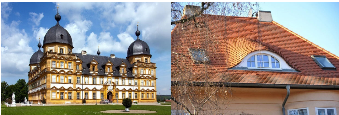
Abbildung 1: Neue Solarpanel eingesetzt in historischen Gebäuden und in Einfamilienhäusern 11
